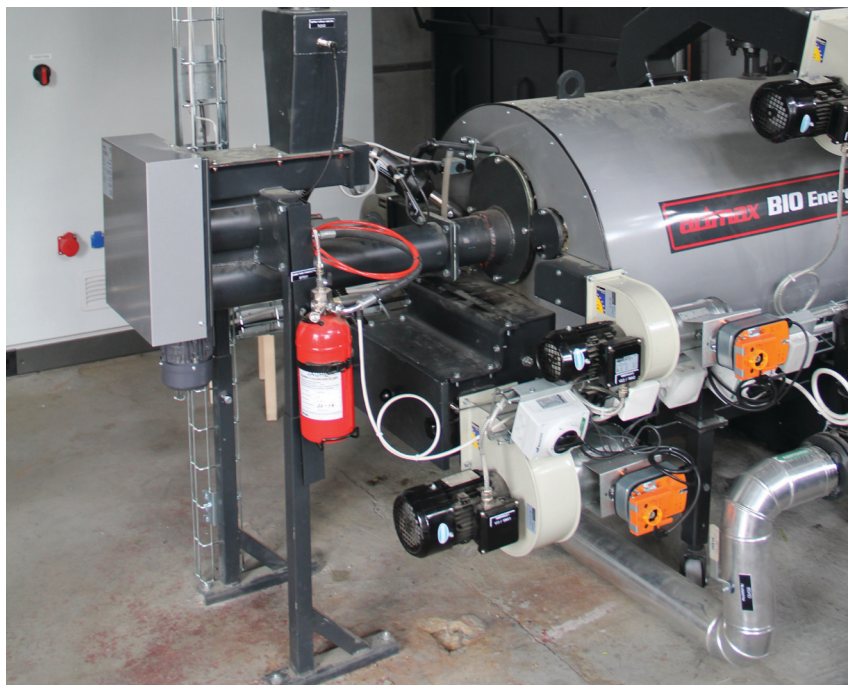
Pelletsmatare PS-10 monterad på BioJet Multi 400 kW-system.
